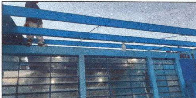
Foto 2: Mantenimiento a estructura de soporte de metal.
