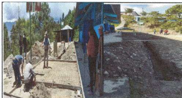
Foto 6: Fundición y reparación de plancha de concreto de patio
