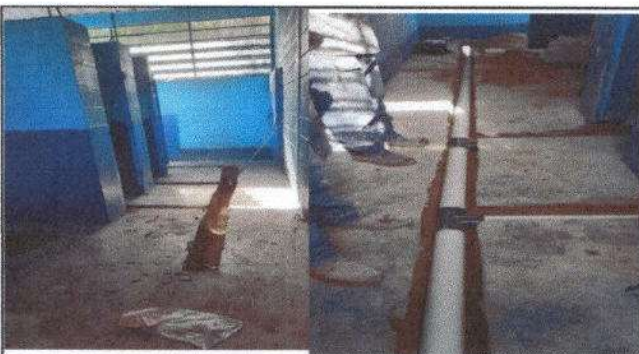
Foto 3: sustitución de un inodoro y sustitución de tubería PVC lineal principal aguas negras.
