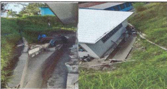
Foto 5: Reparación de banqueta de concreto.
