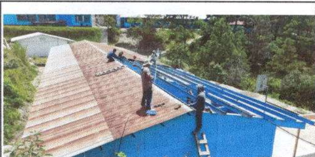
Foto 1: sustitución de lámina, por lámina troquelada aluzin calibre 26.
