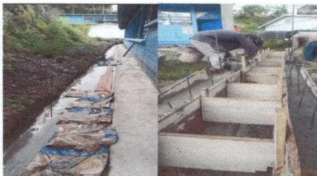
Foto 4: Reparación de cunetas de concreto.
